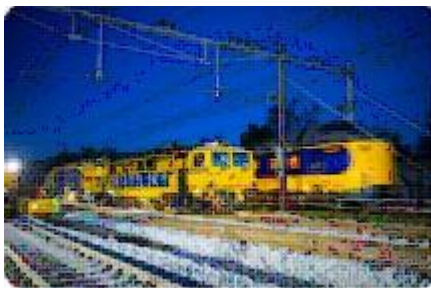
Werkzaamheden bij Weesp
