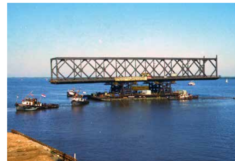
Uitvaren brugsegment Moerdijkbrug (1977)
