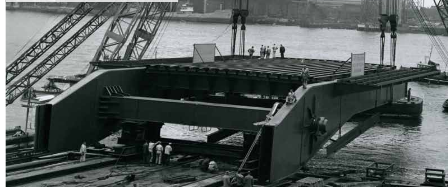
Begin bouw Merwedebrug 1960
