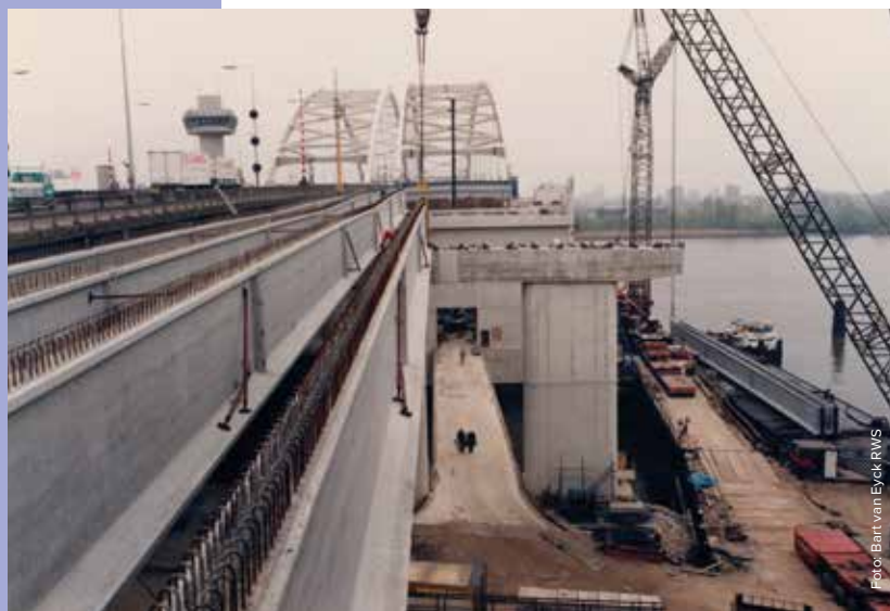
Aanleg van BrienoordbrugII (1989)
