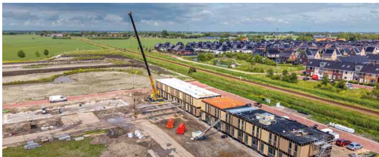
modulaire bouwplaats Sneek
