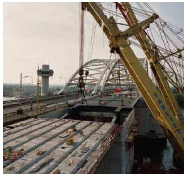
Klep invaren bij de de Van Brienoordbrug (1989)
